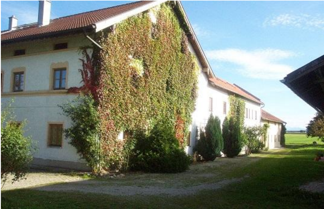
Ansicht aus Nordwesten
